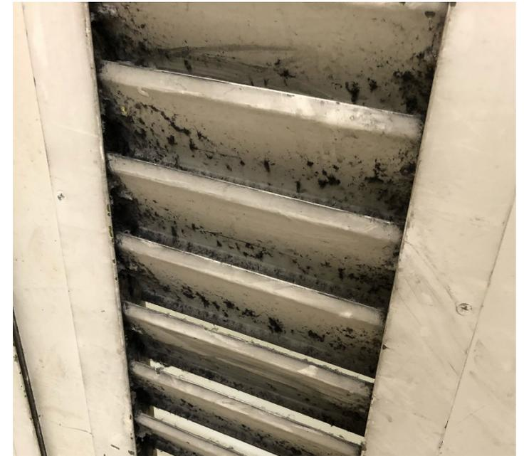
換気口・給気口やフィルターが汚れていると換気性能が低下してしまいます
