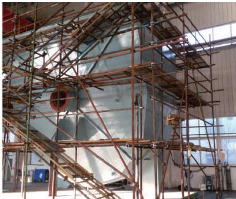
騒音を発生させる機器（ファン）用の消音器の設計、製作を行います。火力発電所向けのボイラーの付帯設備である大型のファン用のサイレンサーは、近隣に大きな騒音を放ち環境問題になるため、必ず消音設備として消音器が設置されます。ファンの種類としては、ボイラーの燃焼用に微粉炭と空気を混合させ燃焼炉に送り込むファン、燃焼炉に空気を送り込むファン、燃焼炉の排
