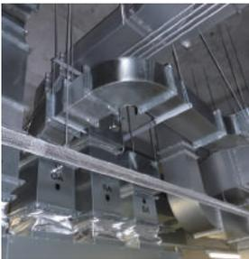
角ダクトの採寸加工を行い、現場で取付工事を行います。
