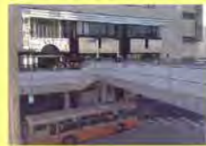
ペDESTリアンデッキとラピス3の接続部は階段のみ
