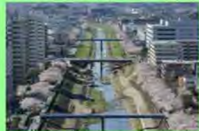
柏尾川プロムナード (距離標がなく、河川敷が暗いなど)
