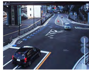
矢羽根型の路面表示の設置
