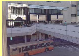
ペDESTリアンデッキとトラピス3の接続部は階段のみ
