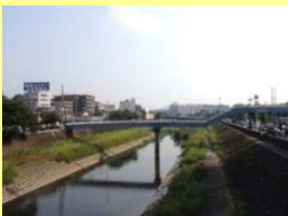
バリアフリー対応されていない元吉倉橋
