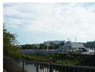
バリアフリー対応されていない元吉倉橋
