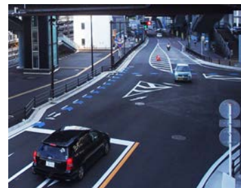
矢羽根型の路面表示の設置
