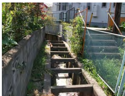
水路 (緑区 柵きょ形式の水路)
