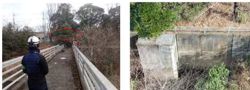
図 7-1 無人航空機を用いた点検実施状況及び撮影画像
