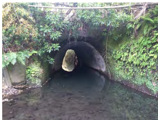
栄区 素掘りトンネル
