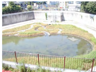
ビオトープ (三保第一雨水調整池)
