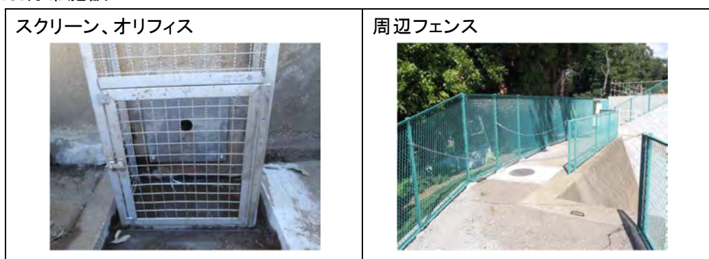
図 1-3 雨水流出抑制施設の付帯施設
