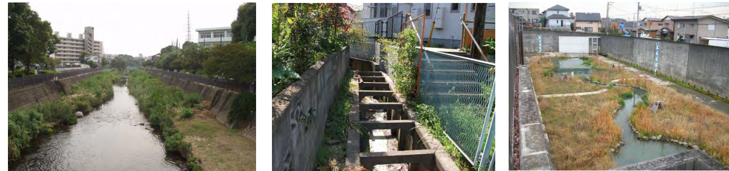
河川 (栄区 二級河川いたち川) 水路 (緑区 柵渠形式の水路) 雨水流出抑制施設 (青葉区 黒須田1号雨水調整池)
