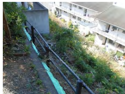
【外周柵の設置】 寺山町本谷特別緑地保全地区（緑区）
