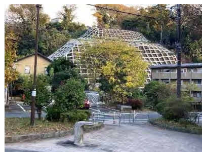
【法面の防災工事】 上郷・中野特別緑地保全地区（栄区）
