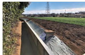
土砂流出防止対策／都筑区
