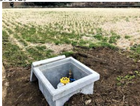
【用水路と給水栓を更新】（緑区）
