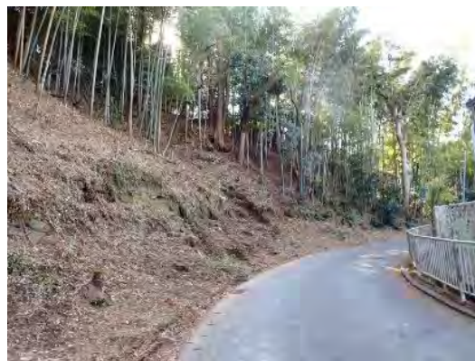
【維持管理の支援】 左：作業前 右：作業後（都筑区）
