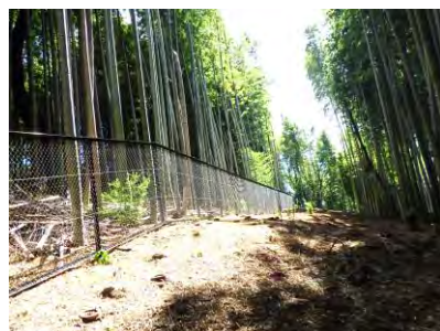
【フェンスの整備】 元石川町平崎特別緑地保全地区（青葉区）
