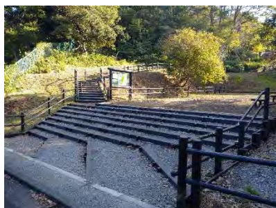
【園路（階段）の整備】 今井境木市民の森（保土ケ谷区）
