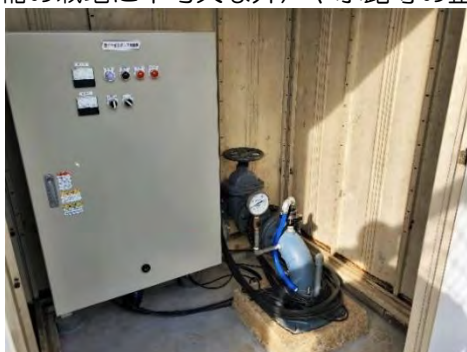
【井戸のポンプ設備を更新】（戸塚区）
