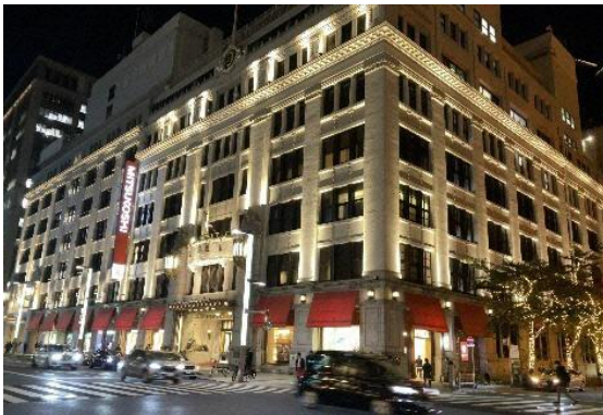
構造を生かした照明演出
