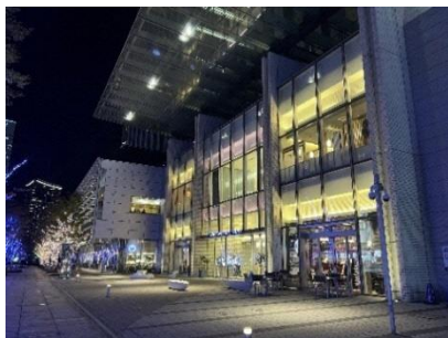
建物低層部店舗の人の温かみを感じられる光 (グランモール軸)
