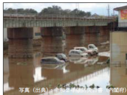
写真（出典）：令和2年台風第19号（内閣府） 郡山市の浸水被害（福島県）
