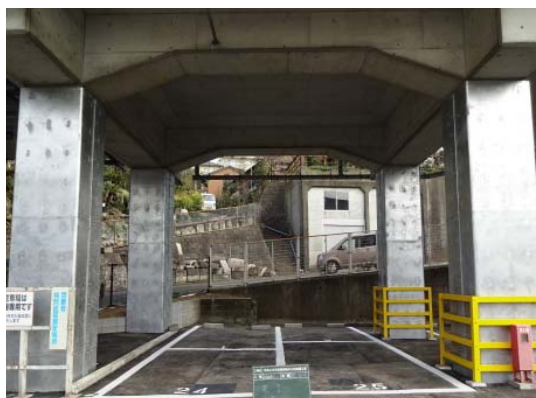
《ラーメン高架橋の橋脚の補強》
