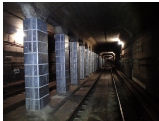
《開削トンネル中柱の補強》
