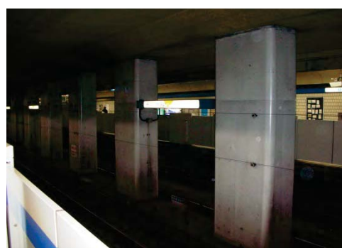
【中柱を補強した開削トンネル】
