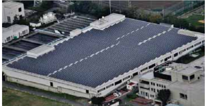
西部水再生センターのメガソーラー (災害時は応急対策に必要な電源を供給)
