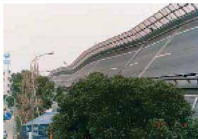
阪神高速道路の高架橋の倒壊
