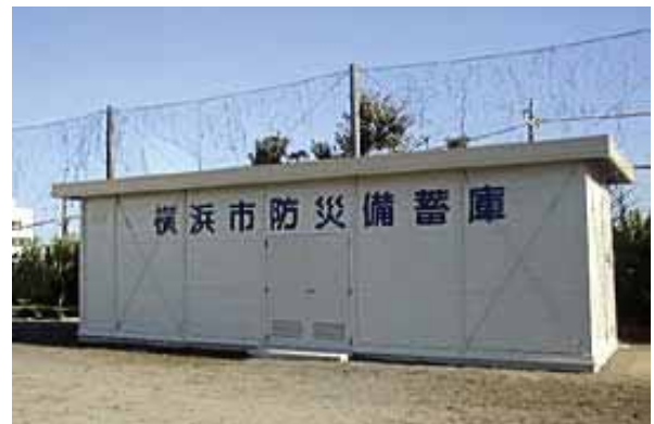
地域防災拠点の防災備蓄庫
