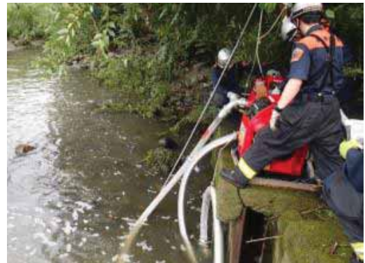
河川からの取水の様子
