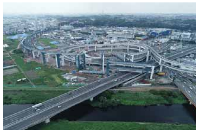
横浜環状北西線（川向地区）
