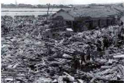
伊勢湾台風の被害状況
