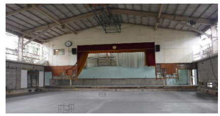
小学校体育館の改修工事
