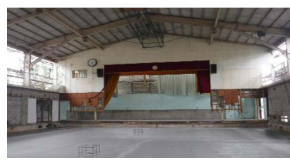
小学校体育館の改修工事
