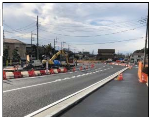
工事状況写真
