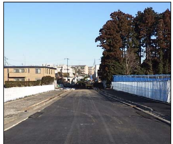
工事状況写真
