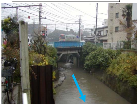
旧金沢橋（下流側から）
