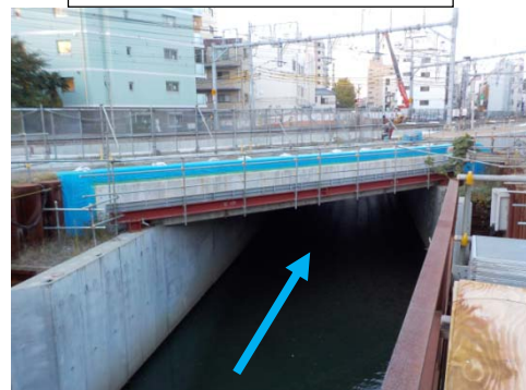
新水路（上流側から）
