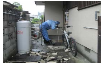
音聴棒による地下漏水調査
