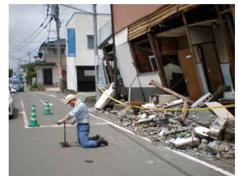
倒壊家屋前でのバルブ作業
