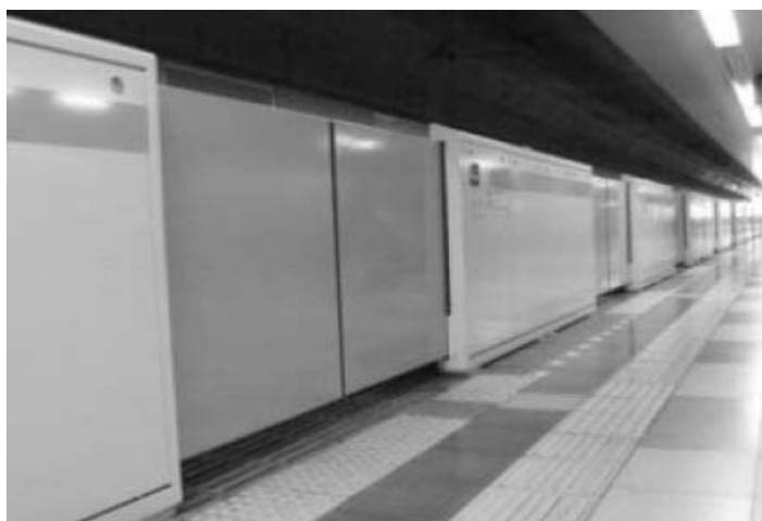
可動式ホーム柵の設置例(国土交通省HPより)
