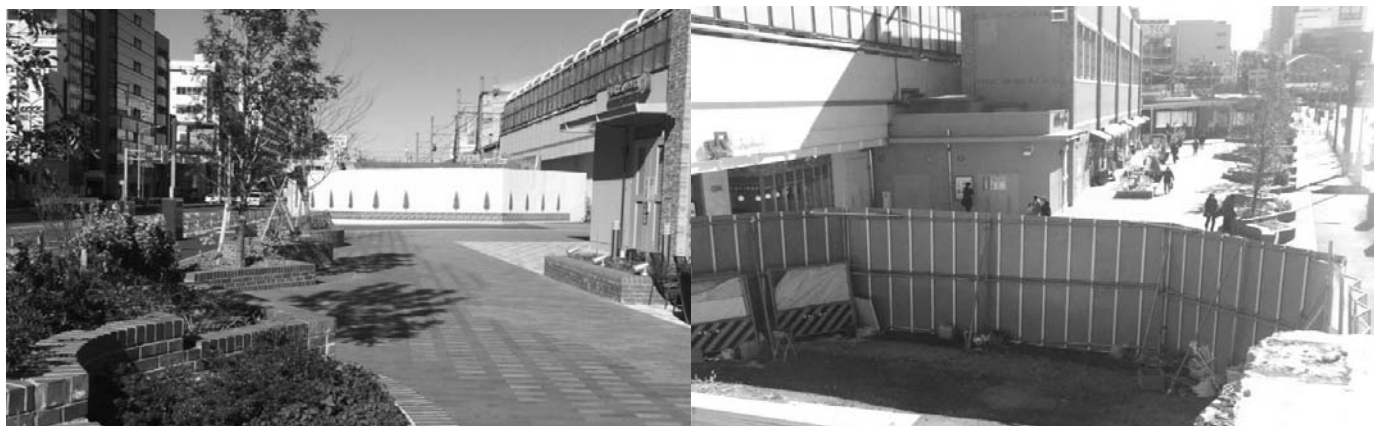
桜木町駅北改札付近の現況
