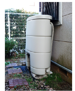
雨水貯留タンクの設置
