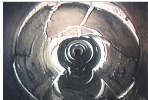
下水道管内の状態を点検・調査
