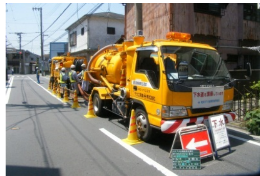
吸引車による下水道管の清掃
