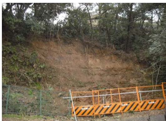
安全対策が必要な斜面地
