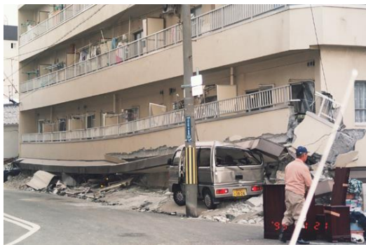
1階のピロティ階が層崩壊したマンション 出典：神戸 災害と戦災 資料館
