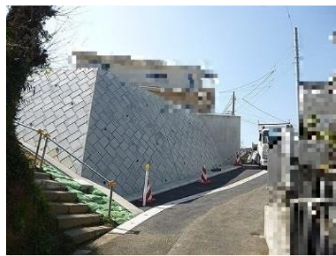
改善後（間知ブロック石積擁壁）
