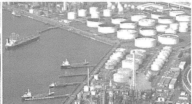
根岸地区 石油貯蔵施設
