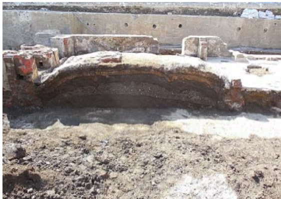
③ 震災で倒壊した建物基礎と変形した床
