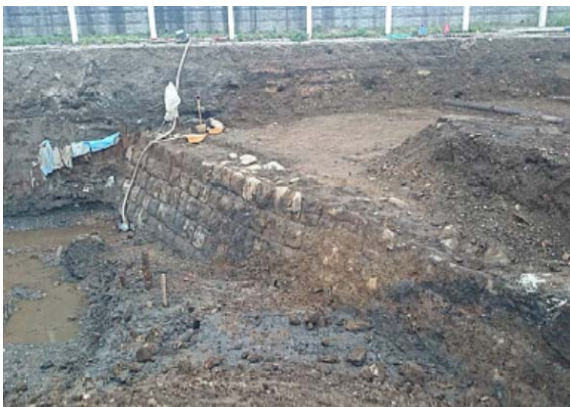
③ 震災で倒壊した建物基礎と変形した床
