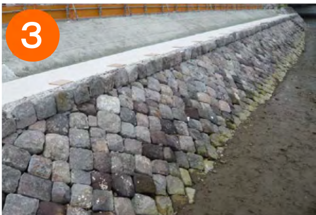
旧灯台寮護岸
