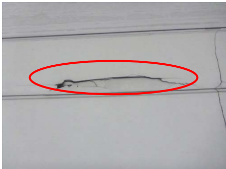
壁板の破損
