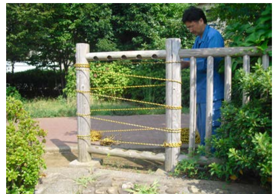
応急対応実施後 (縦格子対応予定)
