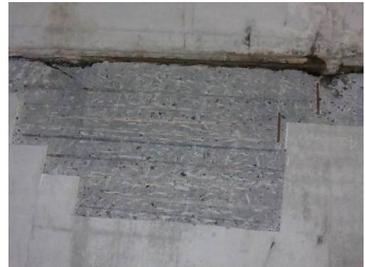
応急対策実施後
