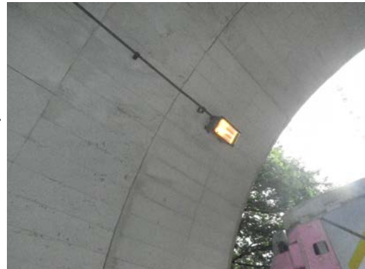
アンカーボルト及び照明器具の修理 完了
