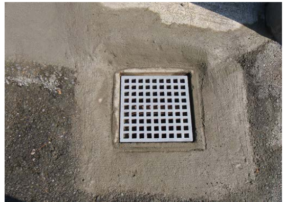
グレーチング柵の交換
