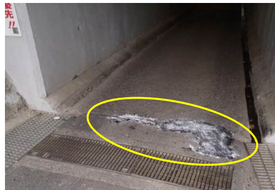
応急対策実施後
