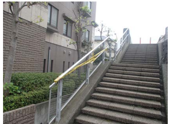
応急措置状況
