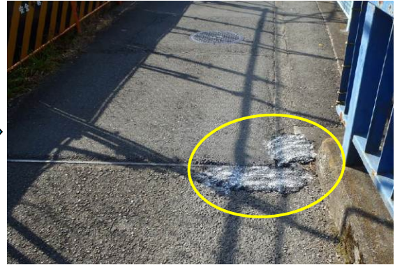
応急対策実施後
