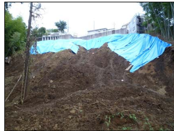
写真6: 防災シート掛け(下部より撮影)
