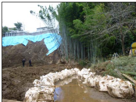
写真7: 仮設の排水経路確保
