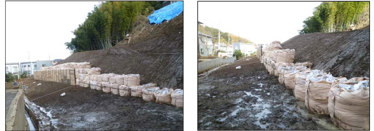
写真8: 仮設防護柵・大型土のう設置
