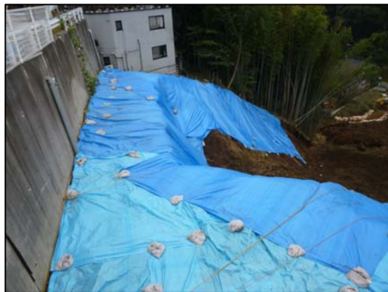
写真5: 防災シート掛け(上部より撮影)
