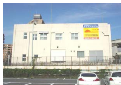
広告媒体としての活用例（楠ポンプ場）
