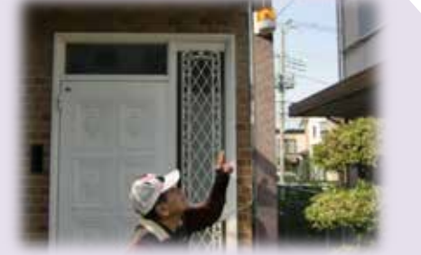
緊急通報装置の取付
