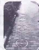
災害用マンホールトイレ
