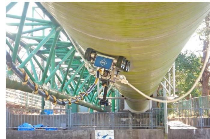
ロボットによる水管橋の点検
