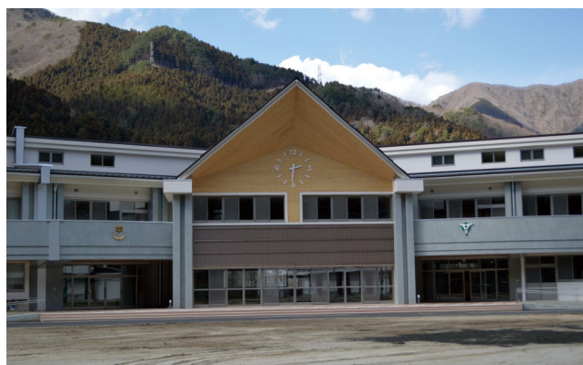
完成した道志小・中学校新校舎
