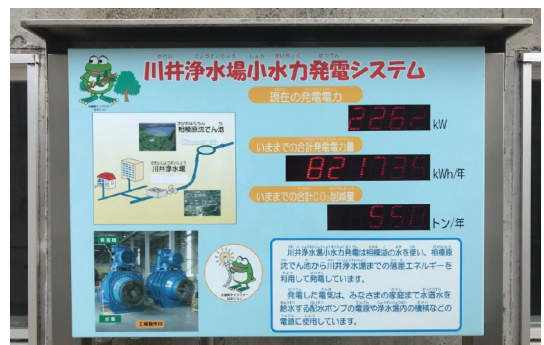
小水力発電の発電量がわかる電子掲示板
