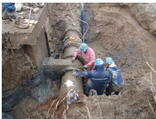
応急復旧隊の活動状況（日立市）
