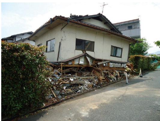
益城町における被害状況
