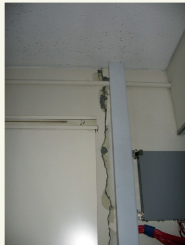
関内中央ビルの内壁の状況
