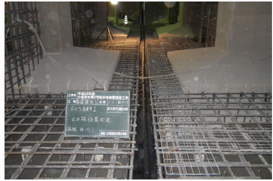
小雀2号配水池耐震補強工事
