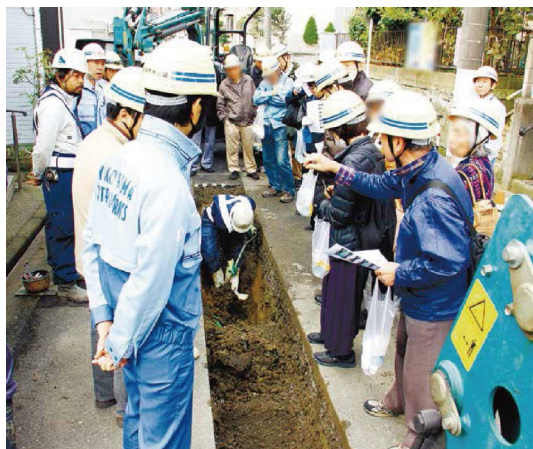
老朽管更新工事現場の特別見学会
