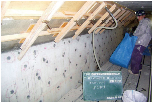
西谷3号配水池耐震補強工事
