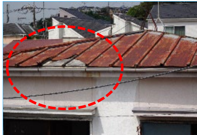
落下しかけの金属屋根材撤去
