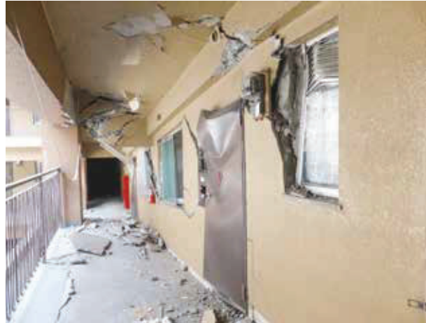
玄関扉の変形が起きると、ドアが開かなくなってしまう事もある。 編集協力者撮影
