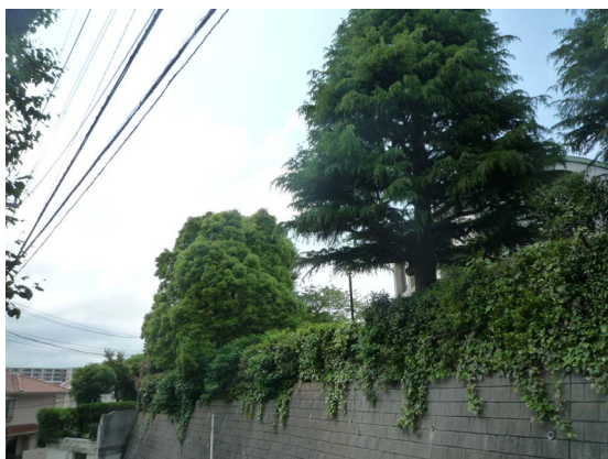
下垂型の植栽などにより擁壁等を緑化している例
