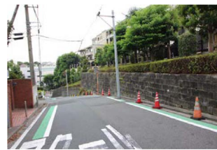
RC 擁壁の前面にブラフ積を積み直して緊結している例
