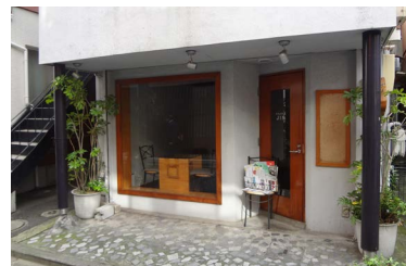
外壁の色彩の配慮を行った例
