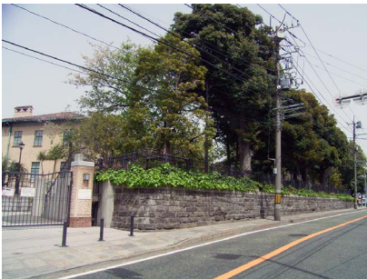
ブラフ積みの擁壁上部を緑化している例
