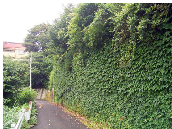
下垂型の植栽などにより擁壁等を緑化している例
