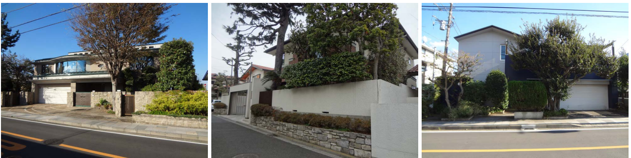
ゆとりある敷地で、敷地境界線から壁面後退し、緑化を積極的に行っている例
