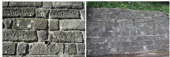
重力式擁壁の表面にブラフ積の石材を化粧材として貼り付けている例
