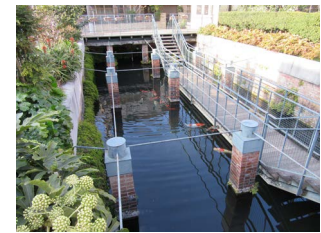
14. ジュラル水屋敷地下貯水槽
