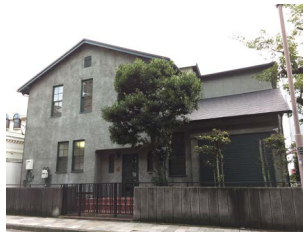
10. フェリス女学院 6 号館別館
