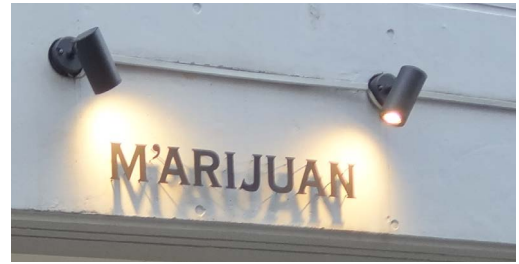
間接照明としている例
