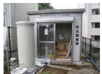
雨水タンク・防災倉庫（防災広場）
