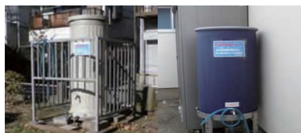
⑤ 雨水タンク設置
