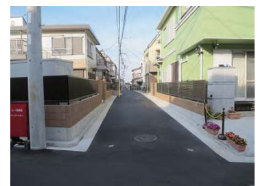
道路拡幅整備後
