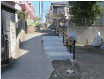
手すりの設置、階段補修（東台会）
