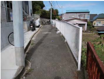
転落防止フェンスの設置
