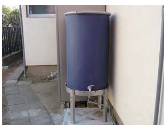
雨水タンク（東久保町会館）
