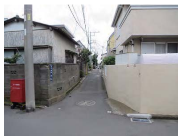
道路拡幅整備前
