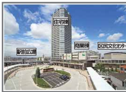
長津田駅北口地区 市街地再開発事業（完了）
