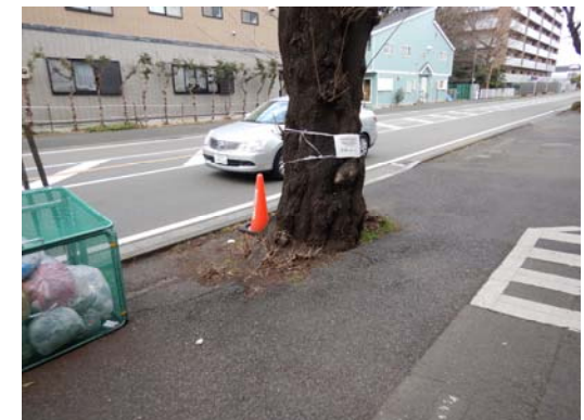
狭小な植栽柵のため、根詰まり、根の巻き込みが見られる。
