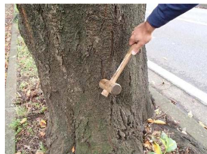
木槌による打診状況
