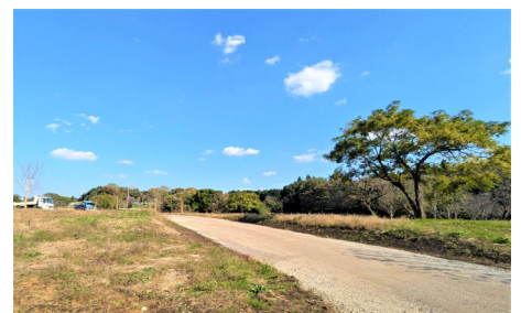
園路の整備状況（公園区域全域）
