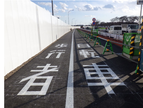
切り替え後のバイパス道路【1】の自転車歩行者道
