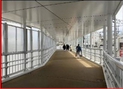
A 大船駅笠間口歩道橋
