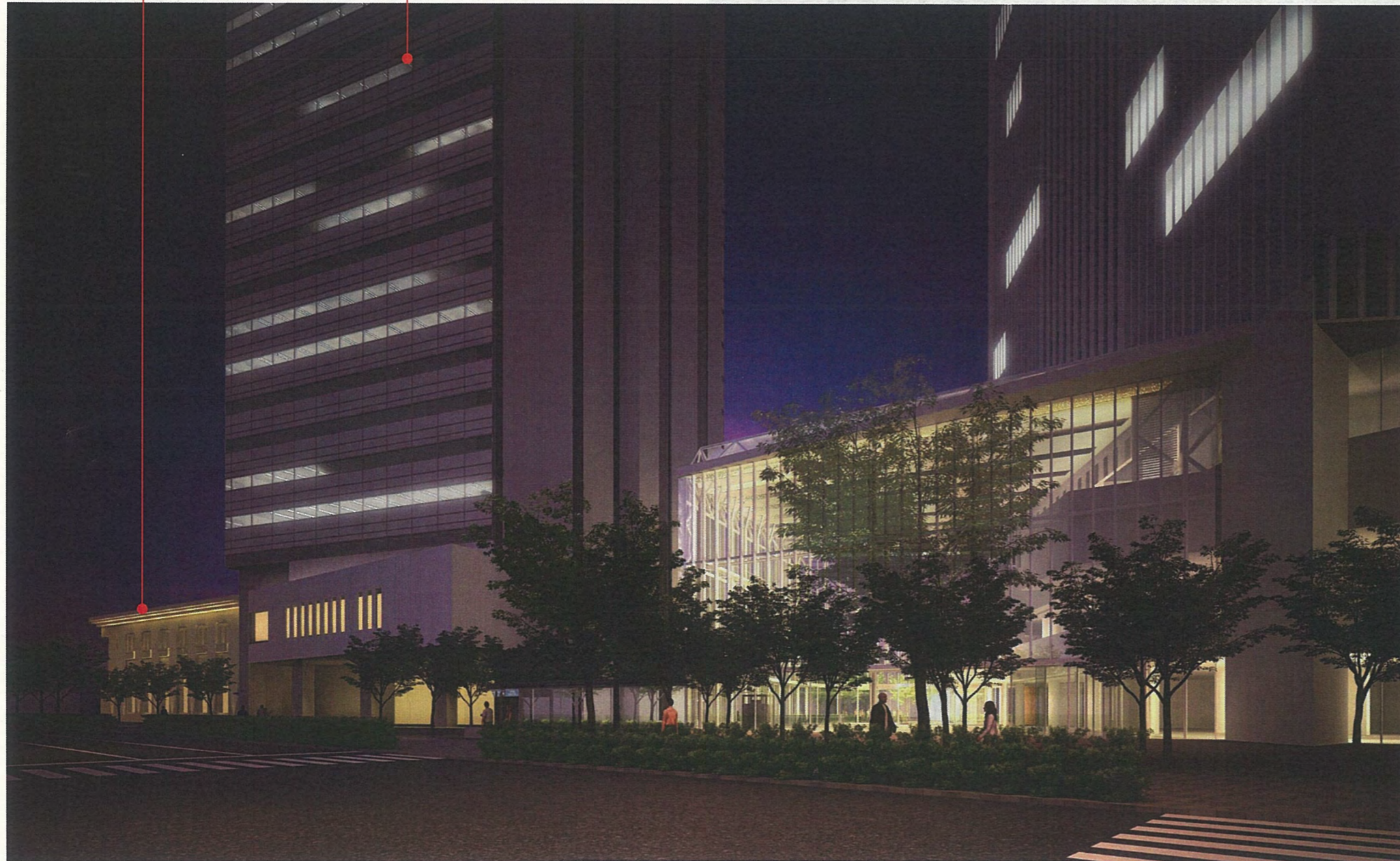
歴史的建造物のライトアップと調和した屋根付き広場の照明計画
