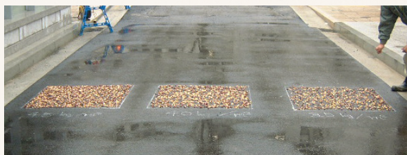
舗装骨材調整中の様子
