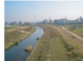
河川 連続したオープンスペースを生かした景観へ
