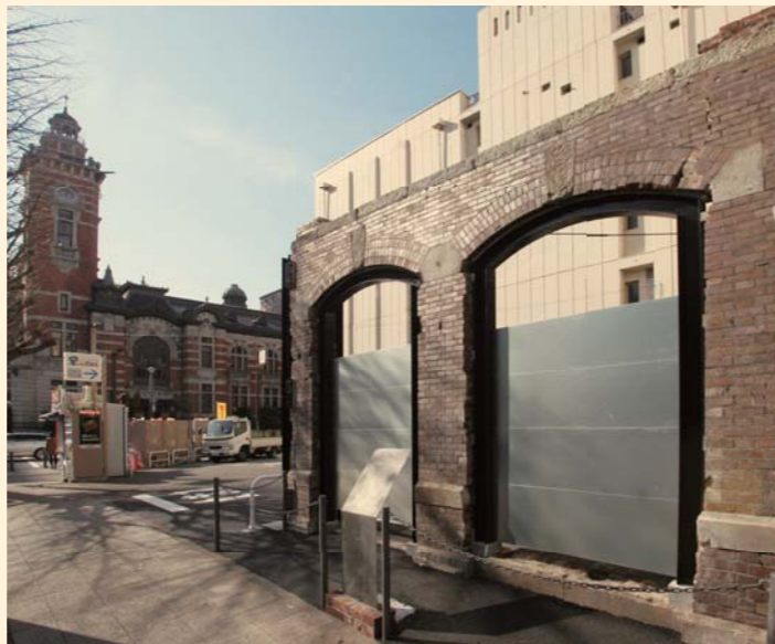
鉄骨補強された外観
