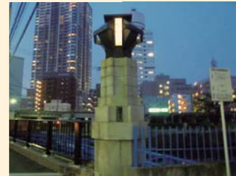
浅山橋親柱(点灯状況)
