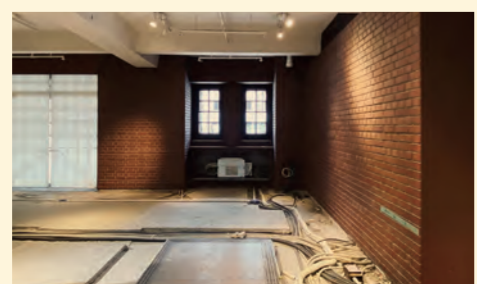
設備更新の様子
