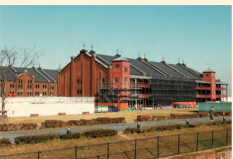
外壁改修工事中の赤レンガ倉庫
