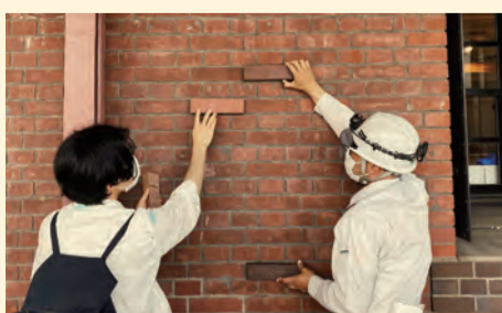
外壁レンガタイルの色合わせ
