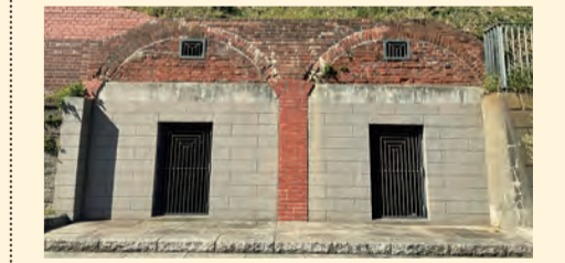
改修後のガス山煉瓦造建造物
