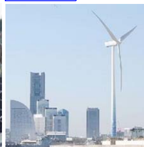
「環境創造局・横浜市風力発電所（ハマウイング）」
