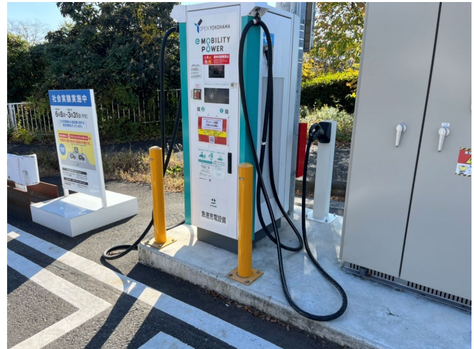
ケーブル延長、ホルダ場所の移設
