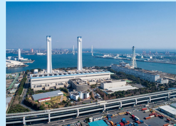
横浜火力発電所の外観
