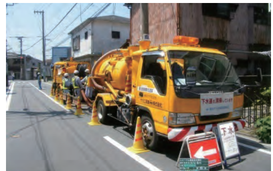
吸引車による下水道管の清掃
