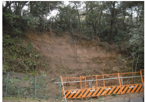
安全対策が必要な斜面地
