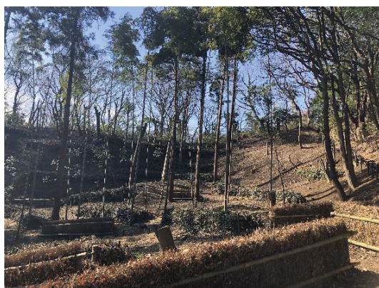
【写真】法面の整備 （戸塚区/名瀬北特別緑地保全地区）
