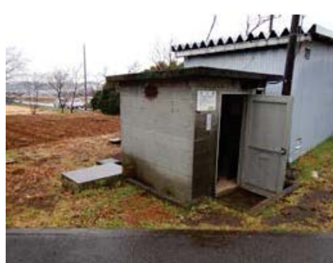
【写真】更新したポンプが設置された機場（青葉区）
