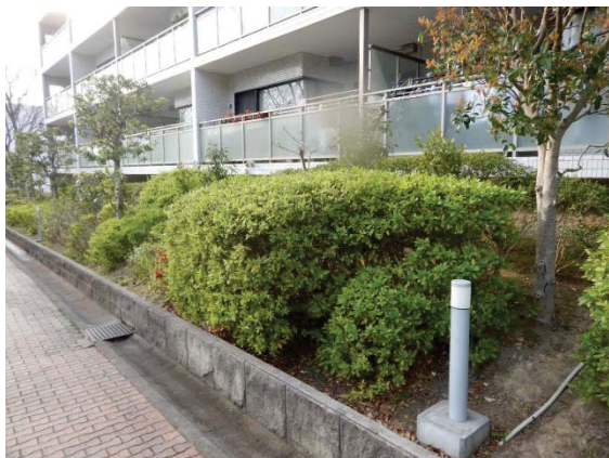
【写真】保全契約の事例〔集合住宅〕（戸塚区）
