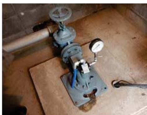
【写真】更新したポンプ（青葉区）
