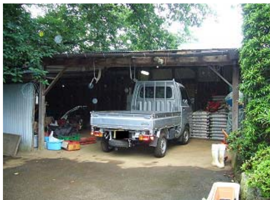
【写真】指定された農業用施設（鶴見区）
